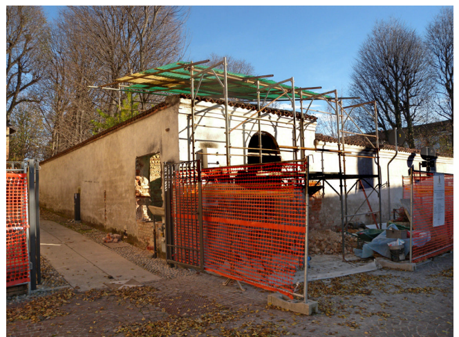
Inizio dei lavori al "ex mortorio"
