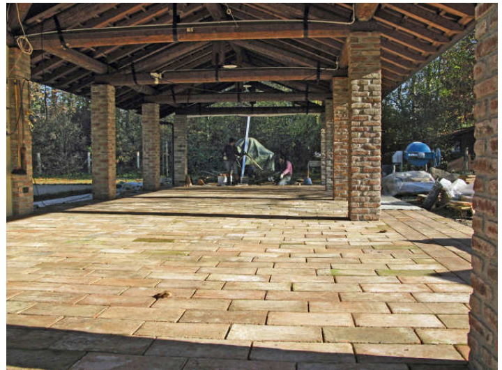
Pavimentazione della barchessa piccola in corso d'opera.
