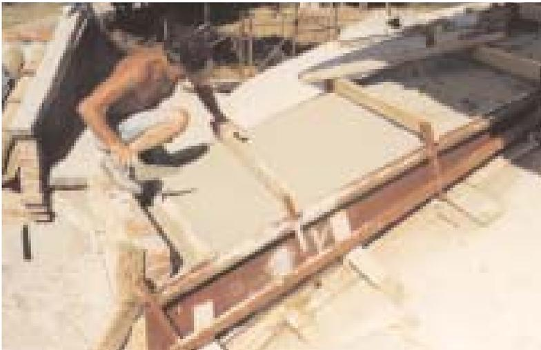
collegati ai cavallotti lasciati sporgere dagli archi, e da una sovrastante rete elettrosaldata con maglia 50x50 Ø 3 mm. Per garantire lo spessore del getto all'attacco della calotta è stato fissato con tasselli espansivi Ø 6 un pro-
